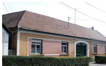
Fő utca 61. Modernizált svábház
