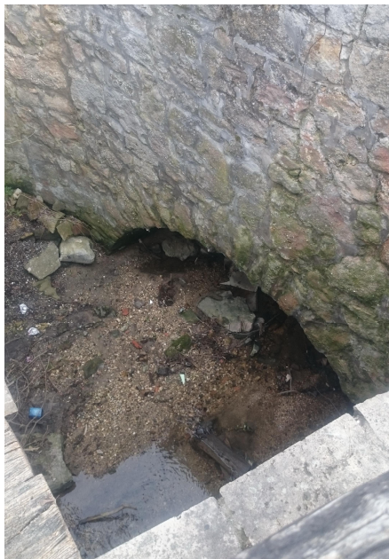
5. Kép - Budai út 30. és Híd utca kereszteződése. Hordalék lerakódás a mederben.
