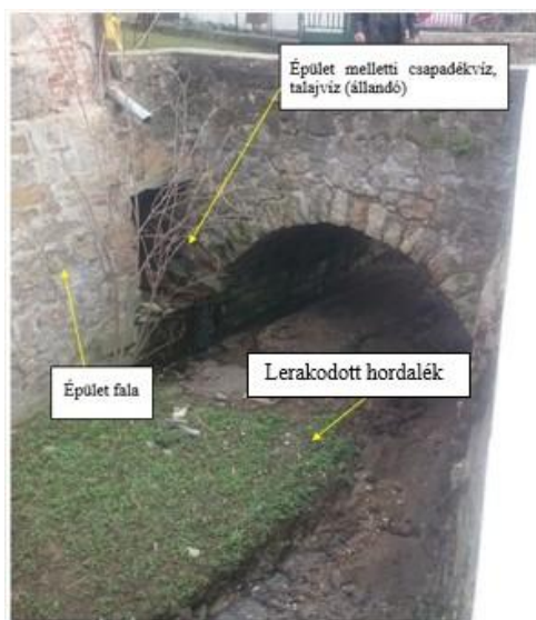
4. Kép - Műtárgy a Budai út 54. és Bárd Ödön sétány kereszteződésében. Hordalék lerakódás a mederben.
