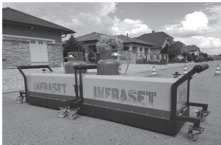
Az Infraset kátyúzógép munka közben
