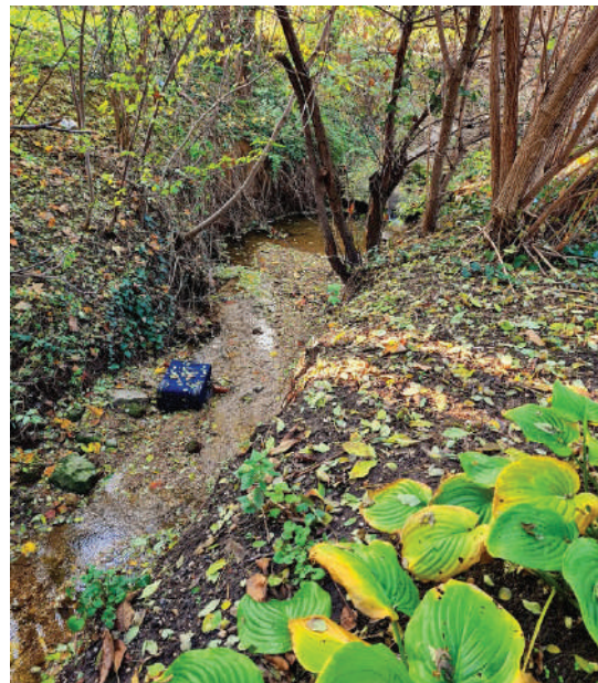
A patakmeder megerősítése is tervben van
